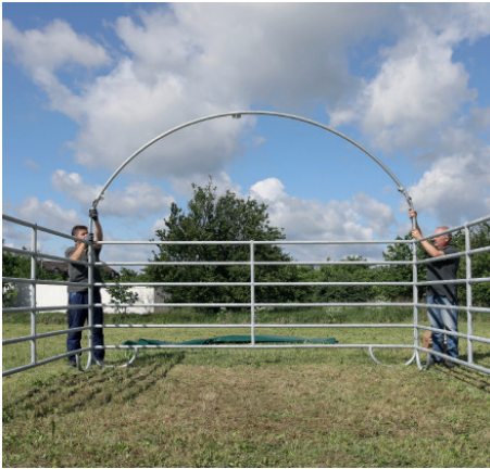
Schritt 11: Anschließend alle Bögen aufstellen.
