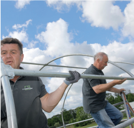
Schritt 13: Nun werden die Druckrohre installiert.
