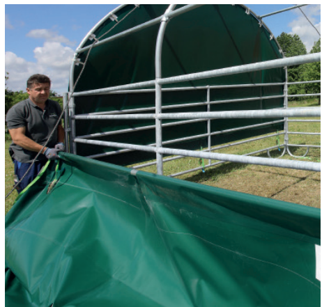
Schritt 21: Befestigung eines Seils am Abspannrohr, welches über die Dachkonstruktion zur gegenüberliegenden Seite geworfen wird.
