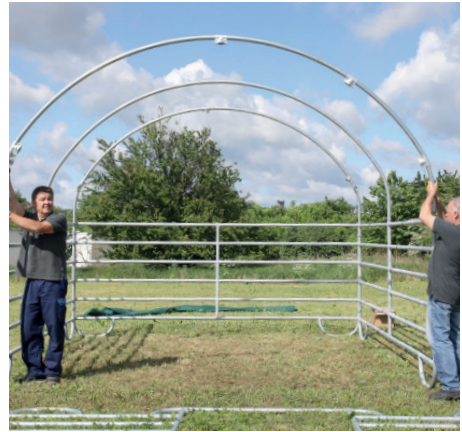
Schritt 12: Die Bögen mit den T-Schellen an den Außenseiten, den Bogen ohne Schellen in die Mitte des Mobil Covers stellen.
