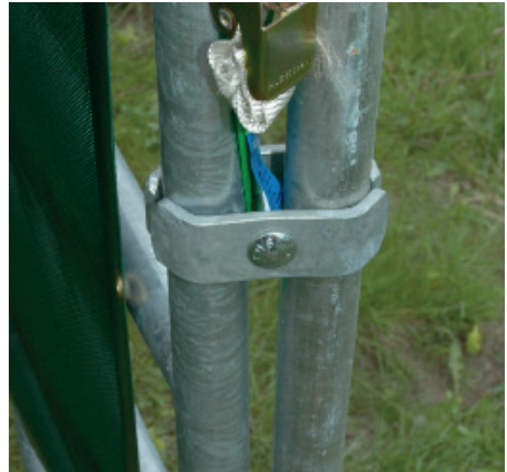
Schritt 19: Befestigung der Panels am Bodenbefestigungsrohr mittels Zaunklammer.
