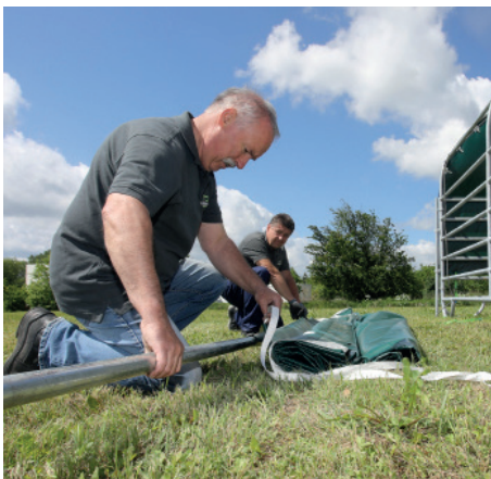
Schritt 20: Ausbreiten der Dachfolie an Längsseite und Einführen der Abspannrohre.
