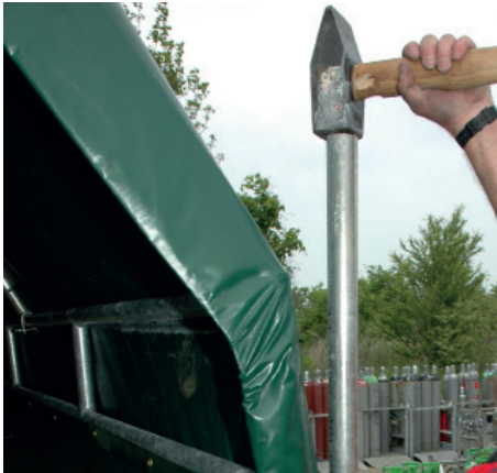
Schritt 18: Eintreiben der Bodenbefestigungsrohre mittels Hammer (Oberkante Bodenbefestigung = Oberkante der dritten Querstrebe von oben).
