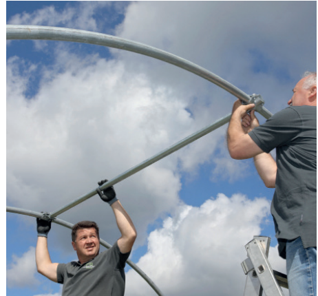
Schritt 14: Mit dem Druckrohr im First beginnen und das Druckrohr dabei bis zum Anschlag in die T-Schelle stecken.
